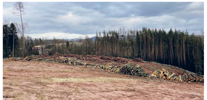
Na trase obchvatu Náchoda už probíhají těžařské a další přípravné práce.
